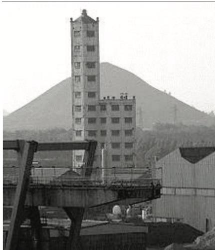
**Fig. 5.5** – Tour à plomb de l'Usine Métaeurop-Nord (démolie en 2006) où ont été fabriquées des dizaines de milliards de billes de grenaille de plomb de chasse.
